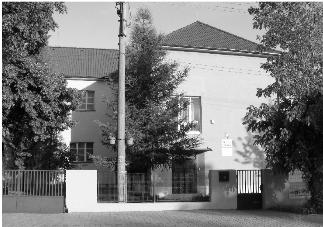
Budova materskej školy. Predtým bola budovou základnej školy. (Foto: archív)
